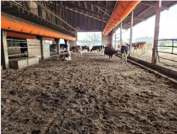
Abbildung 5 Milchviehstall (innen) mit Schlauchlüftung (orange)
